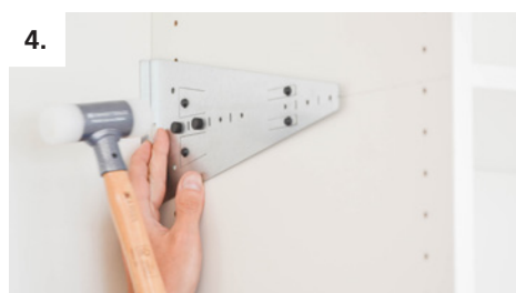
4. Posizionare la dima di tracciatura sulla parete posteriore e contrassegnare i punti di foratura
