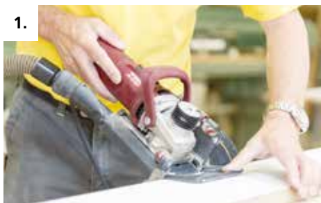
1. Fresare la scanalatura del P-System
